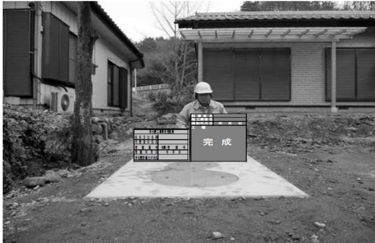
写真(完成状況)
